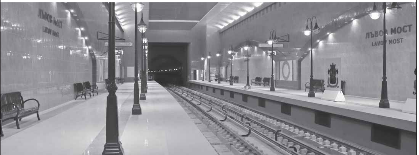
Метростанция „Лъвов мост“
